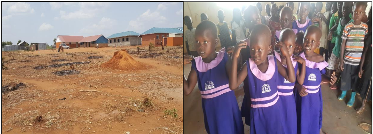
<부지 확장 공사>
